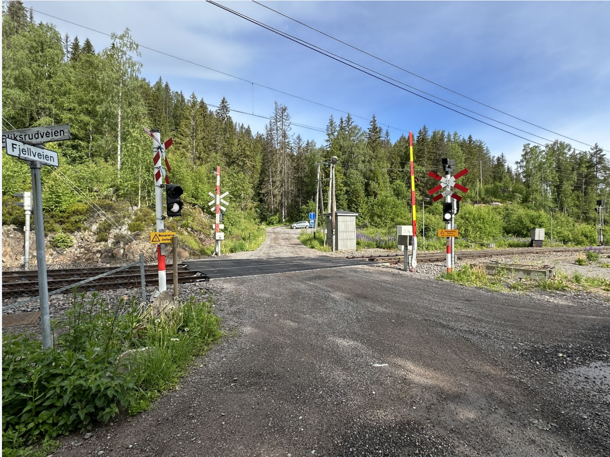
(Foto: Nittedal kommune, Planovergang Åneby stasjon, 10.06.2024)
