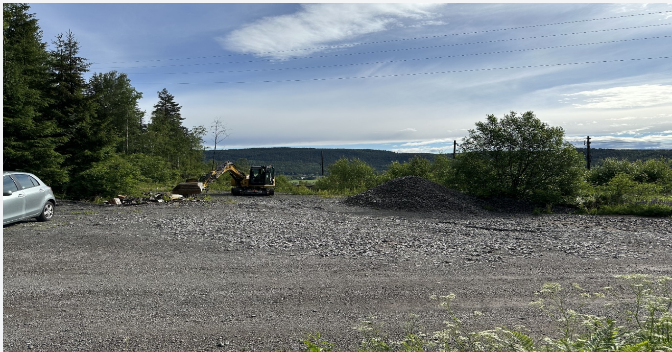
(Foto: Nittedal kommune, Opparbeidet privat område 10.06.2024)
